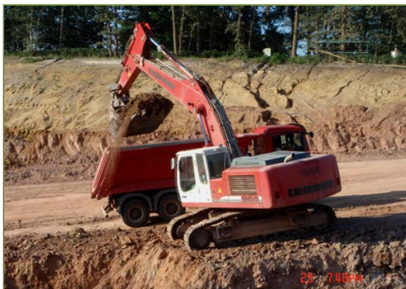
Pelle en cours de chargement d'un camion
