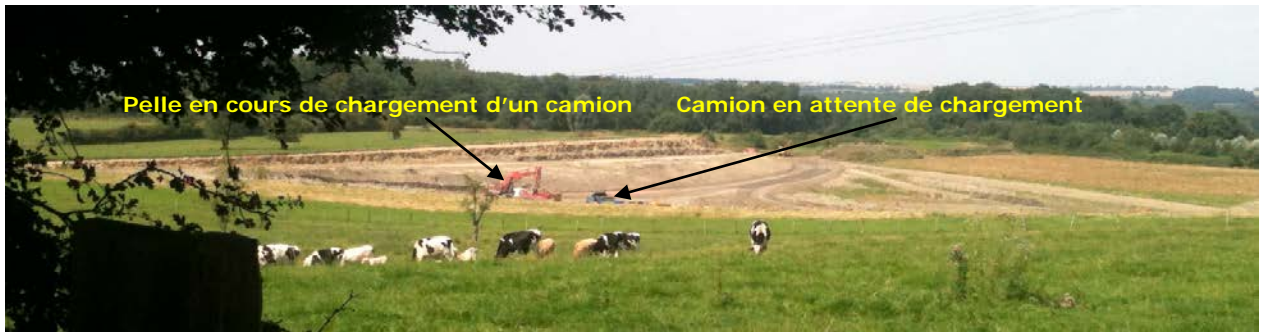
Vue générale actuelle de la carrière depuis l'Est
