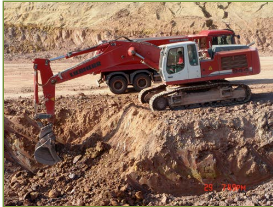
Extraction à la pelle mécanique en mode rétro
