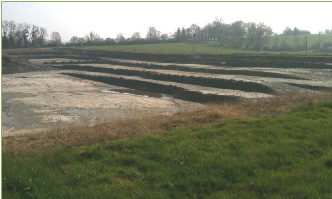
Vue d'un front de taille recoupé en gradins de 2,5 m en cours d'exploitation
